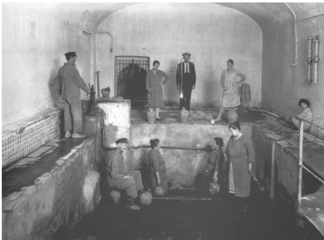
Fig. 2- Sorgente del Chiatamone: interni; anni Trenta (da Arch. Troncone in Archivio Parisio 1998).
