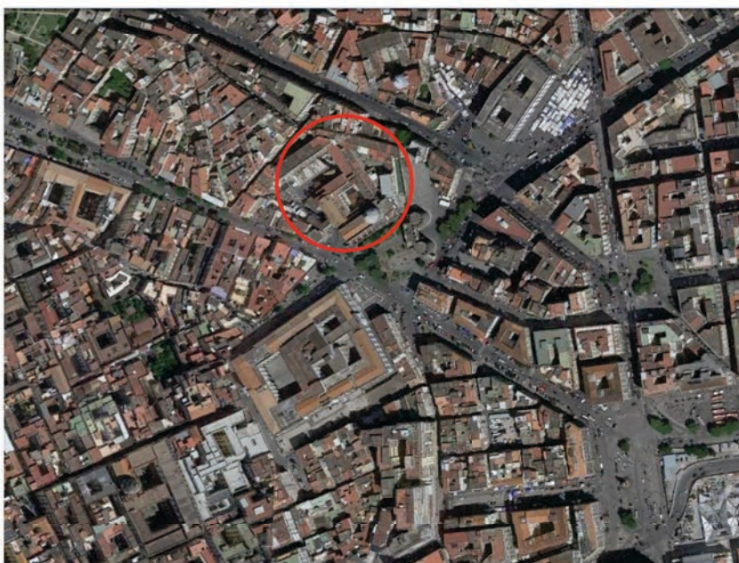
Vista dall' alto dell' Ex lanificio Sava appartenente al Complesso di Santa Caterina a Formiello
