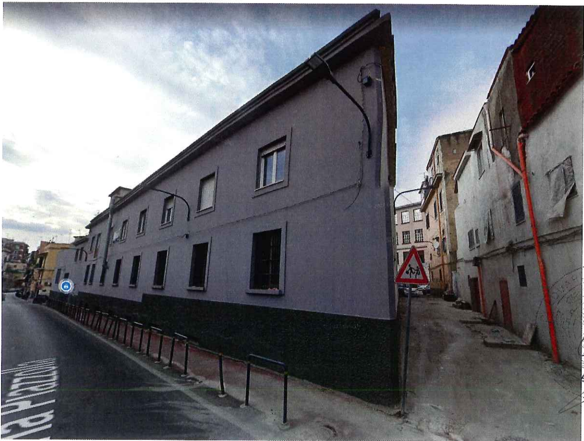
Foto 2: La stecca edilizia su via Piazzolla al Trivio ad angolo con Cupa Loutrec, ricostruita negli anni '50 con Licenza Edilizia n° 133/1954
