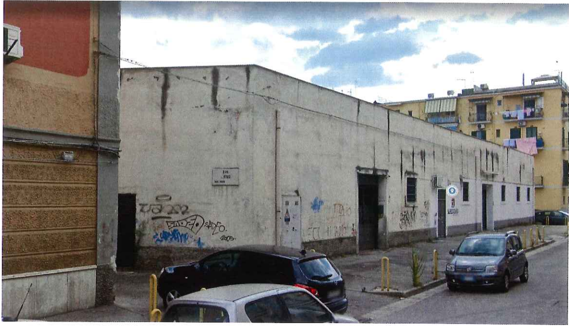
Foto 7: Il Capannone d'impianto a maglia doppia su via F. Manlio visto dall'angolo della Cupa Loutrec
