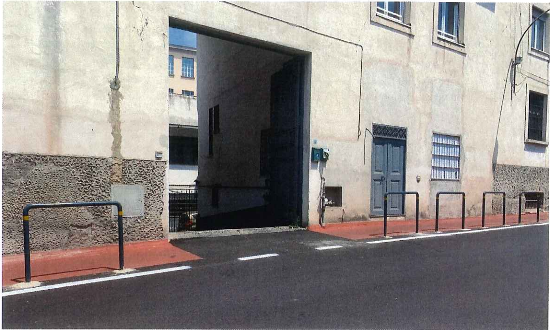
Foto 3: L'ingresso carrabile su via Piazzolla al Trivio verso la rampa che conduce al livello interrato
