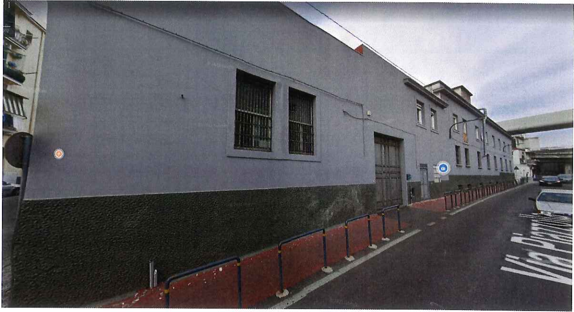
Foto 1: L'intero fronte del complesso edilizio su via Piazzolla al Trivio Da sinistra: la parte terminale del capannone su via Turiello, androne e la palazzina uffici in muratura d'impianto, seguiti in aderenza dalla stecca edilizia ricostruita negli anni '50
